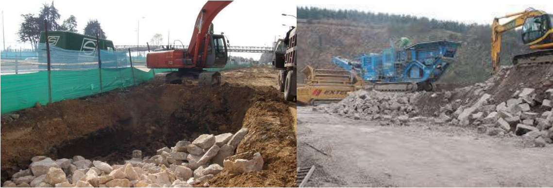
Ilustración 3.5.6-24. Empleo de material de demolición para el mejoramiento de subrasante
