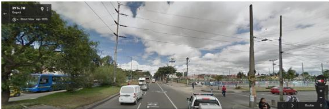
Ilustración 3.4.8-6. Red aérea de alta tensión Transversal 74 F Sur (Av. 1ra de Mayo) entre Calle 41 sur y Calle 40 Sur. Fuente: Google Earth
