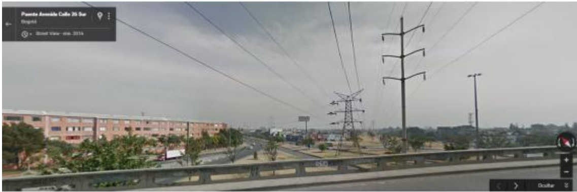
Ilustración 3.4.8-7. Red aérea de alta tensión Transversal 51 con Carrera 68 y Calle 26 sur (Av. 1ra de Mayo). Fuente: Google Earth
