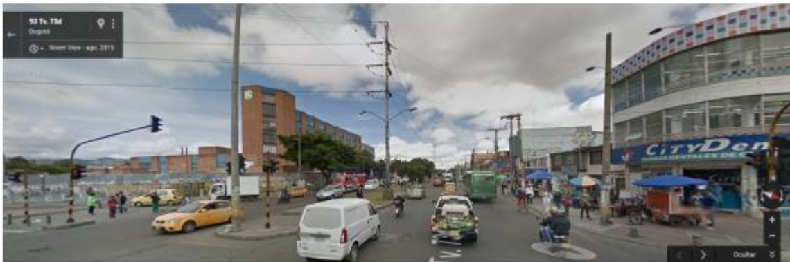
Ilustración 3.4.8-5. Red aérea de alta tensión Transversal 74 F Sur (Av. 1ra de Mayo) entre Calle 41 sur y Calle 40 Sur. Fuente: Google Earth
