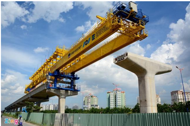
Ilustración 3.5.6-4. Viga lanzadora para viaducto en "U" del metro de Ho Chi Minh
