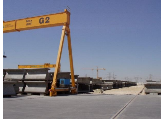
Ilustración 3.5.6-11 Doble acopio de dovelas en parque de prefabricación para metro de Dubái
