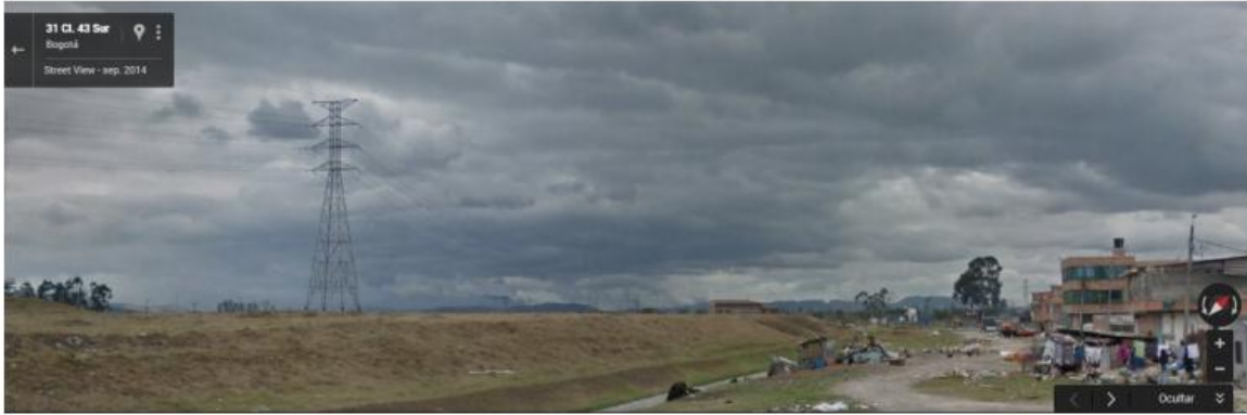
Ilustración 3.4.8-4. Red aérea de alta tensión Avenida Villavicencio entre la Avenida Tintal y Río Bogotá. Fuente: Google Earth
