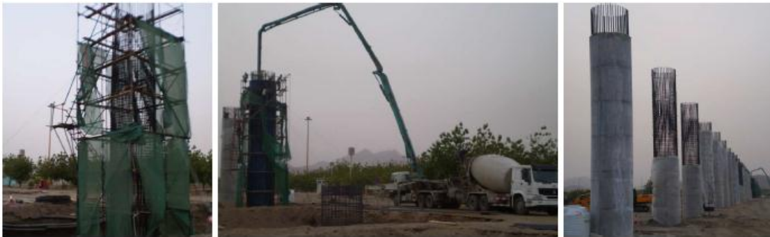
Ilustración 3.5.6-2. Construcción in-situ de elementos de subestructura. Fuente: SYSTRA
