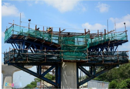
Ilustración 3.5.6-3. Construcción de capitel in-situ. Fuente: SYSTRA
