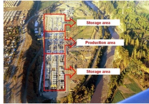
Ilustración 3.5.3-2. Vista de parque de prefabricación para Línea 4 de Metro de Santiago de Chile
