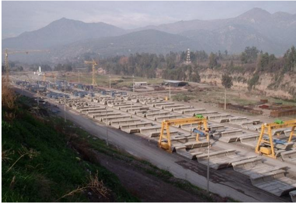
Ilustración 3.5.6-10. Zona de acopio en parque de prefabricación (línea 4 metro Santiago de Chile)
