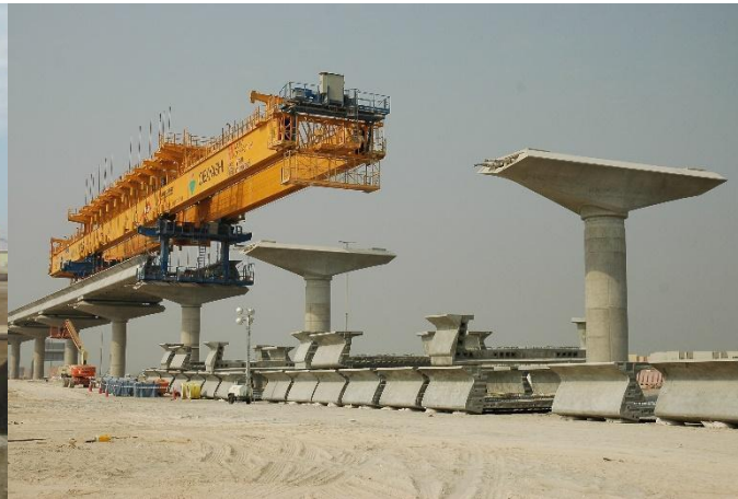
Ilustración 3.5.6-13. Ubicación de dovelas con viga lanzadora. Acopio de dovelas en obra previo a montaje con viga lanzadora
