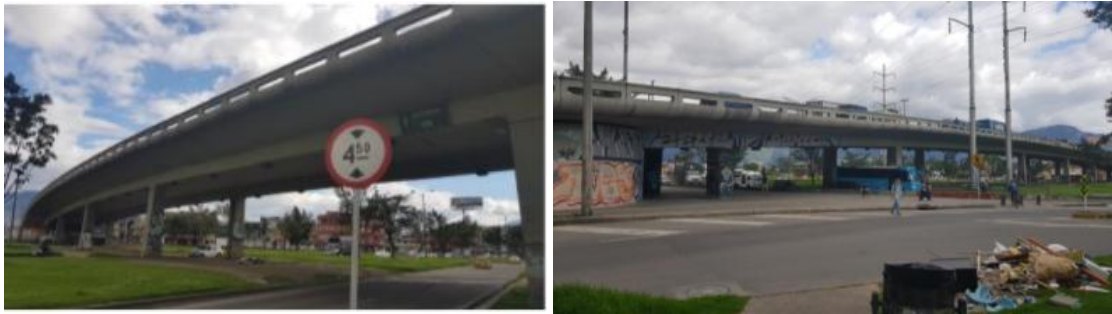
Ilustración 3.4.8-3. Puente vehicular de la Av. 1ro de Mayo con Avenida Carrera 68. Ejemplo de puentes que presentan interferencia con el proyecto. Fuente: Propia Consorcio MetroBog
