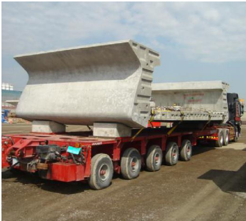
Ilustración 3.5.6-12. Transporte de dovelas del parque a obra mediante camión-remolque
