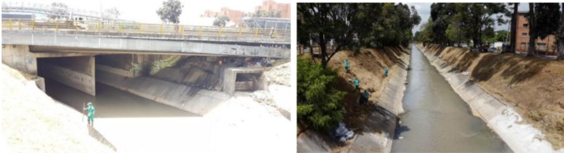
Ilustración 3.4.8-1. Canal Fucha – Vista Aguas Abajo. Ejemplo de canales interceptados por el proyecto sin afectación. Fuente: Propia Consorcio MetroBog
