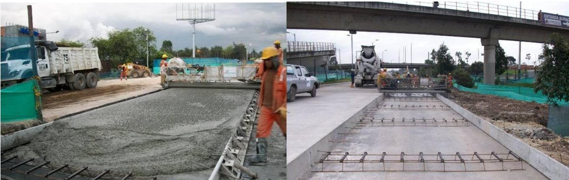
Ilustración 3.5.6-25. Construcción concreto neumático carril BRT
