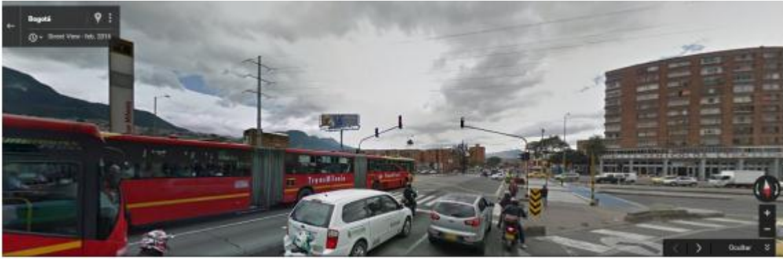
Ilustración 3.4.8-10. Red aérea de alta tensión Calle 6ta con Carrera 14 (Av. Caracas). Fuente: Google Earth
