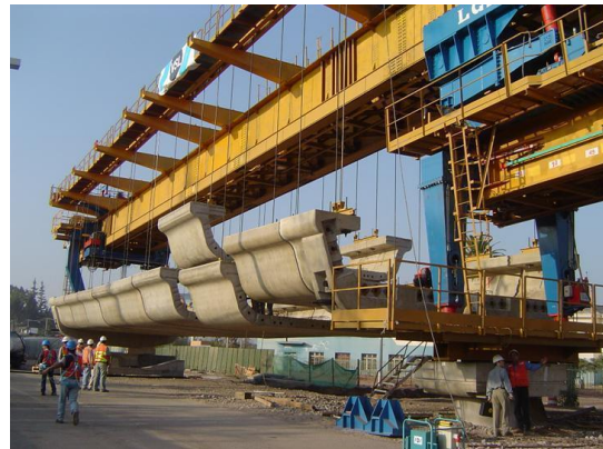
Ilustración 3.5.6-5. Izado de dovelas mediante viga lanzadora (metro de Delhi)
