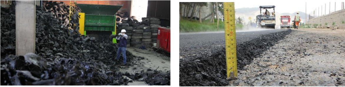
Ilustración 3.5.6-26. Construcción de capa de rodadura con la utilización de material reciclado de llantas
